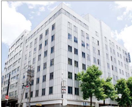
トヤマビル本館
